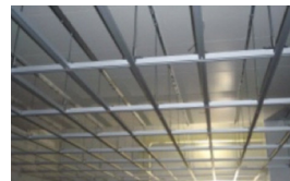
공기 단속 및 오차 불허의 Module화된 Mold-Bar 설치
